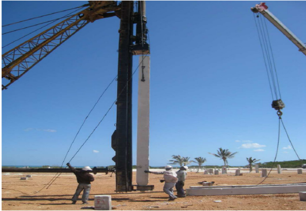
Figura 1. Proceso de hincado de pilote, buscando verticalidad en el martillo delmag.
