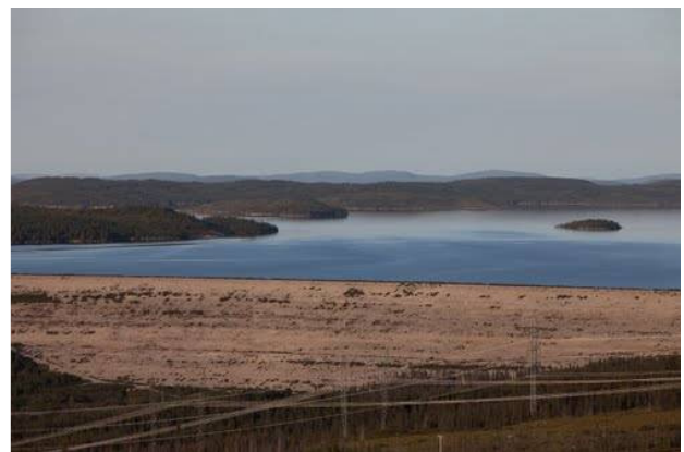
Fig.8. La Grande 4 (LG4) Main Dam, Québec
