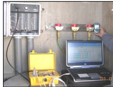
Figura 8. Equipos de medición de celdas de asentamiento
