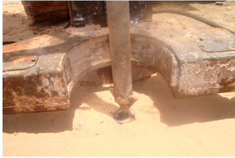
Figura 1. Tubo de refuerzo auto-perforante para pilote Anker
