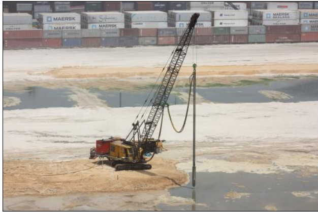
Figure 5. Vue d'un atelier de vibro-compactage
