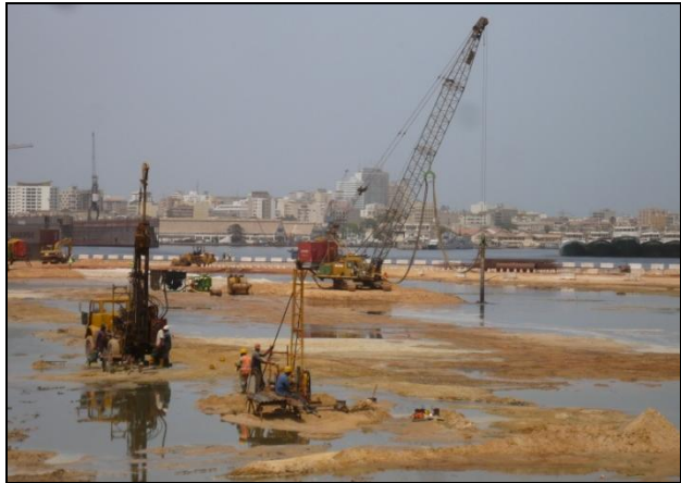
Figure 8. Vue des ateliers de forages de contrôle
