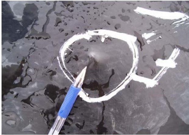
Figura 4. Daños encontrados en la geomembrana
