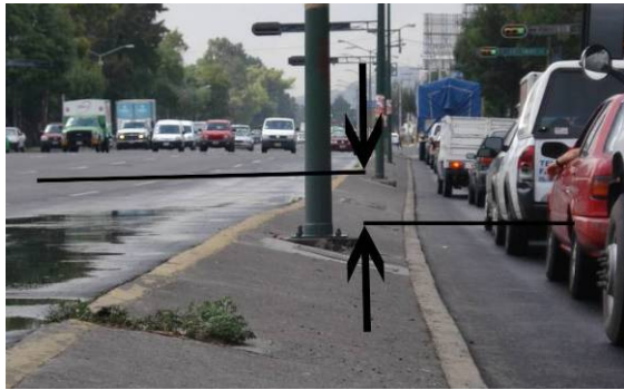
Figura 12. Imagen de la Calzada Vallejo mostrando el desnivel provocado por los rellenos de la calzada prehispánica
