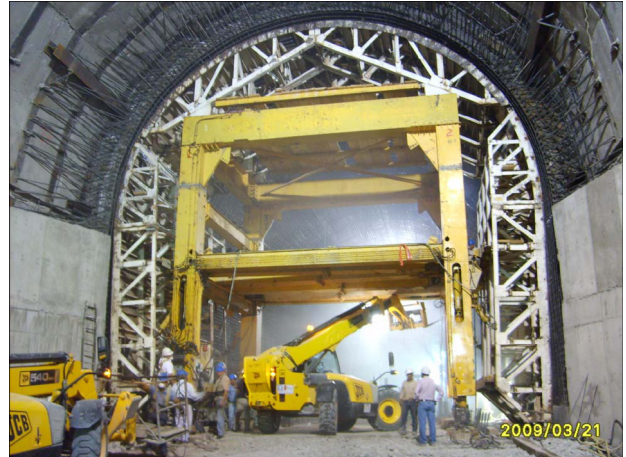
Figura 7.2 Revestimiento definitivo
