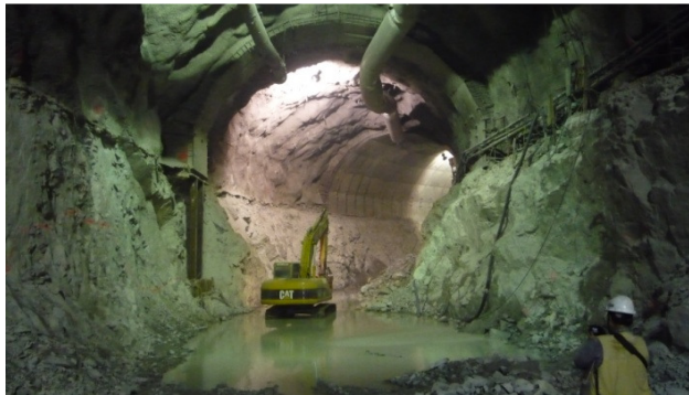
Figura 7.1 Excavación del Túnel de Desfogue
