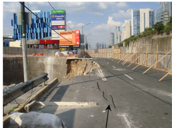
Agrietamiento incipiente
