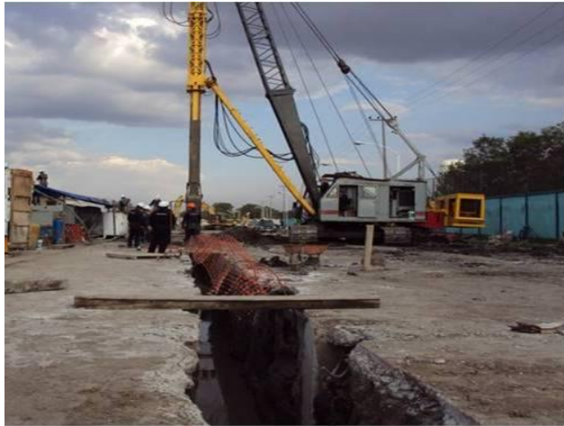
Figura 5. Construcción de pantalla con firme de concreto como brocal
