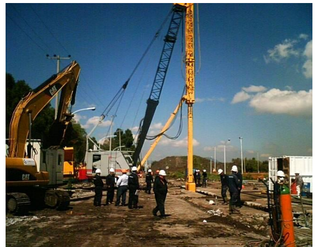
Figura 8. Excavación de pantalla con almeja hidráulica con Kelly entero.
