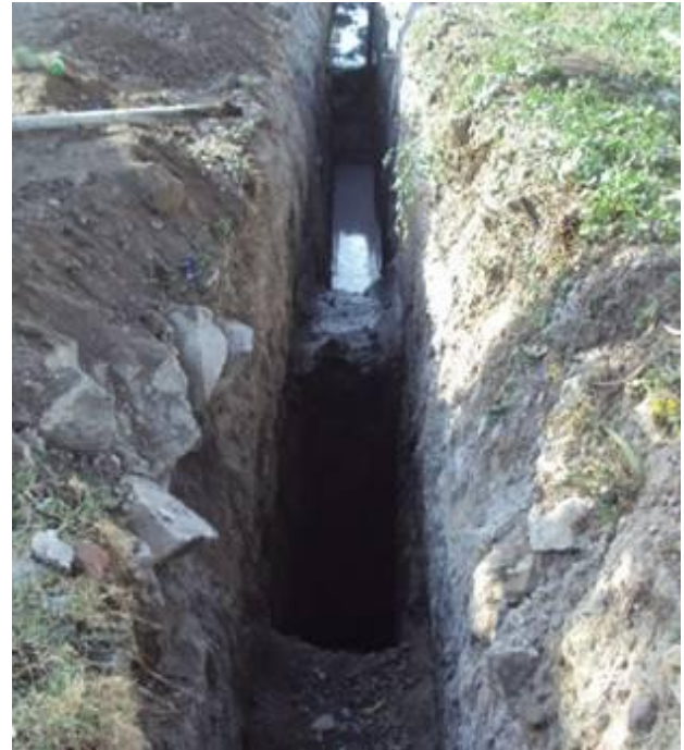
Figura 7. Secuencia de excavación de pantalla
