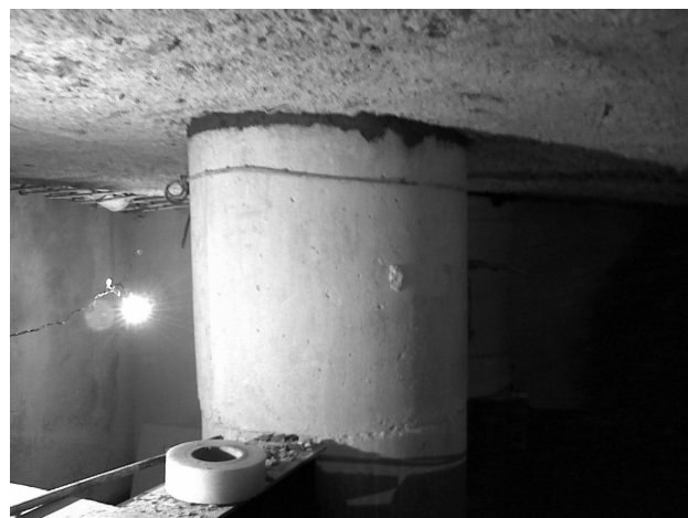
Figura 22. Se muestra la colocación del grout sobre la superficie superior del pilote para recibir nuevamente a la zapata de cimentación.
