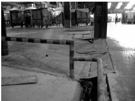
Figura 20. Se aprecia como los pisos del primer nivel se renivelaban .
