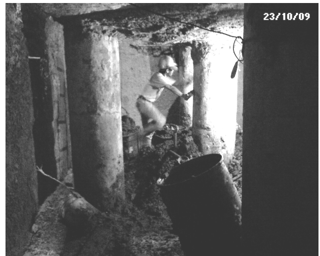
Figura 5. Excavación bajo las zapatas
