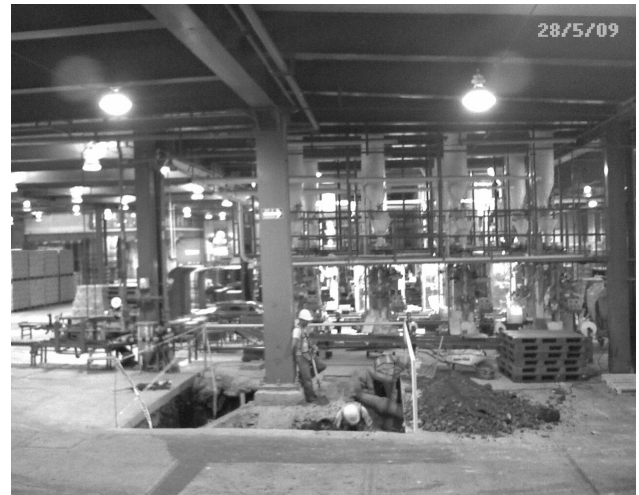
Figura 4. Excavación sobre las zapatas
