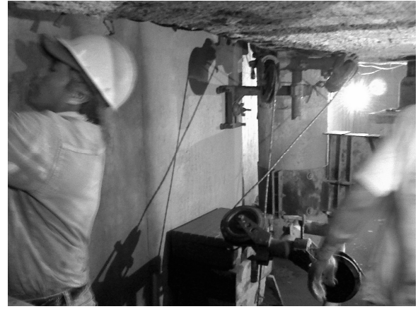
Figura 19. Trabajos de corte en pilotes en zapata tipo Z-3
