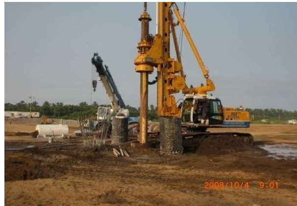
Figura 6. Construcción de pilas
