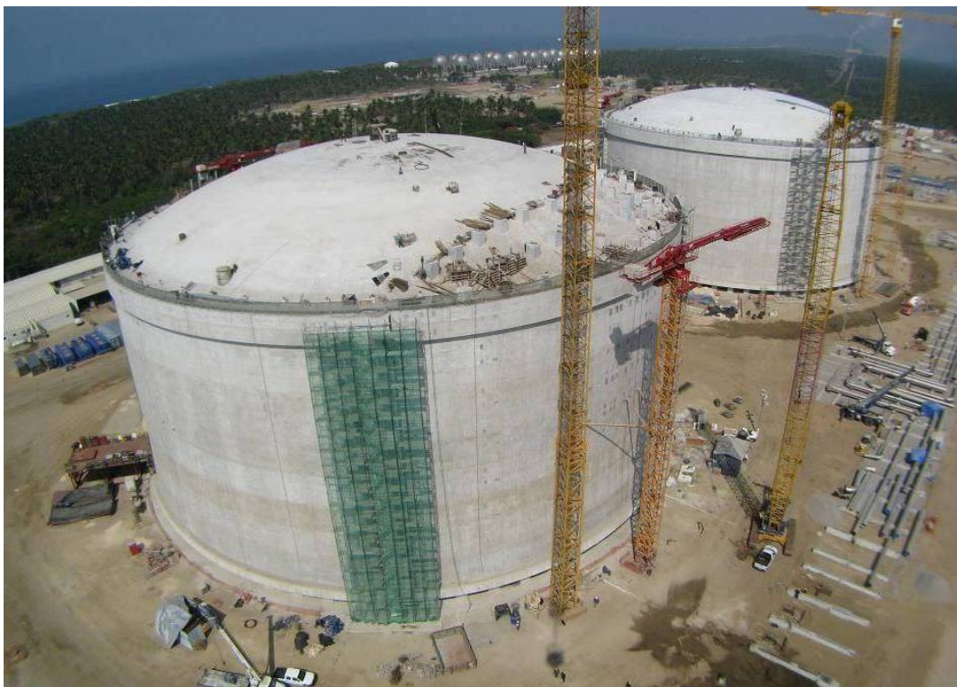
Figura 14. Avance de los trabajos en Mayo de 2010, cortesía Samsung.Manzanillo.
