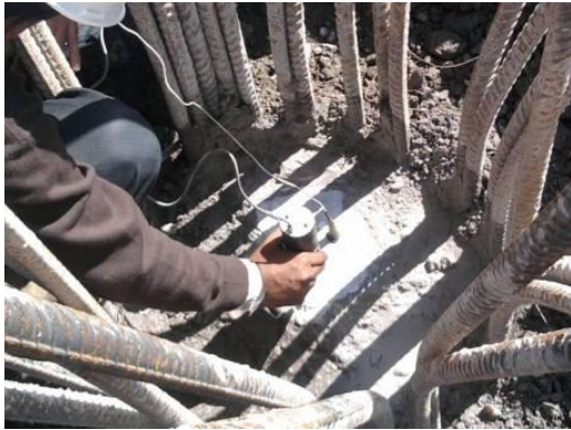
Figura 4. Ejecución de prueba de integridad
