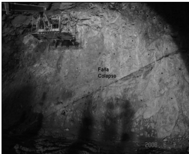
Figura 3. Vista de la falla Colapso dentro del túnel de desvío 1.
