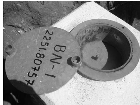
Figura 12. Detalle del Banco de Nivel instalado por CFE en el cerro Tlapacoya.
